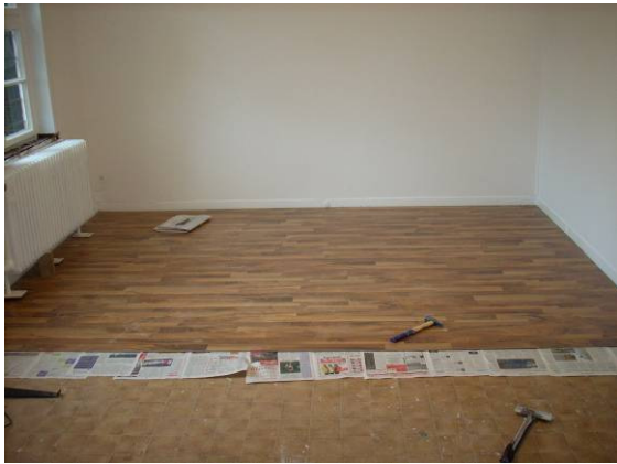
Bild 5: Der neue Boden wird verlegt
